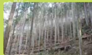
防災林の整備(丹波市柏原町) 伐倒木を利用し土留め工を設置。下草が育ち、降雨による土壌の流出を防止
