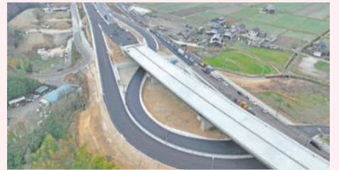
3月に開通した東播磨道の八幡三木ランプ
