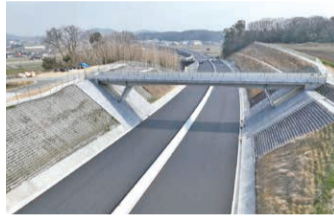
3月21日に開通した東播磨道片山地区(下村高架橋南側)。
