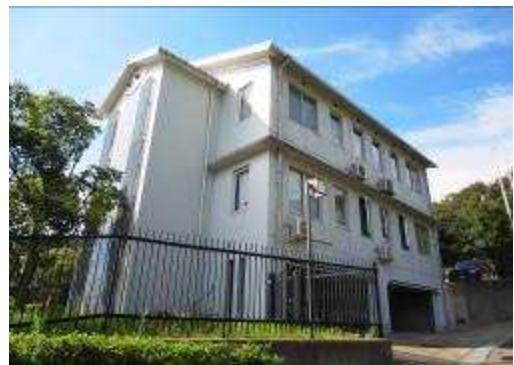
淡路食肉衛生検査所
