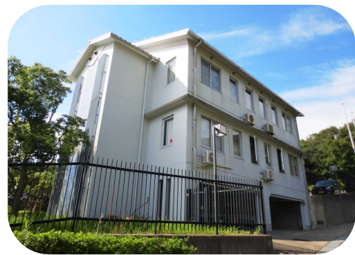
淡路食肉衛生検査所
