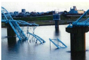
和歌山市水管橋崩落事故状況 (事故調査委員会報告書引用)
