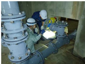
浄水場着水井改築工事現場確認状況
