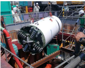
管渠シールドマシン設置状況
