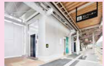
鉄道駅舎エレベーター設置
