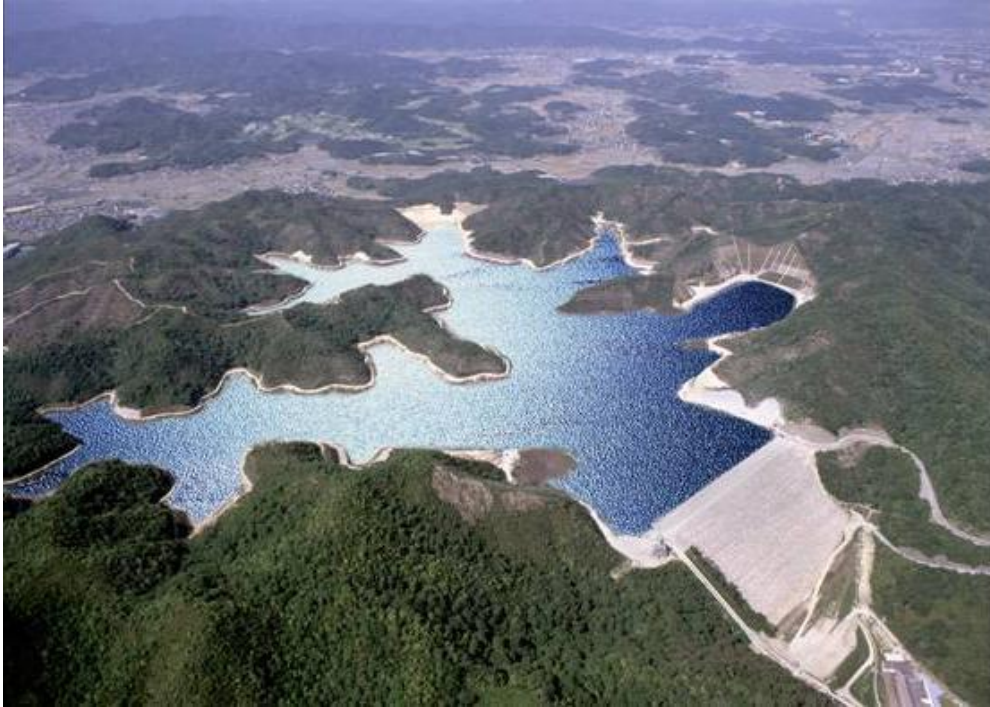
神谷ダム (船津浄水場水源)
