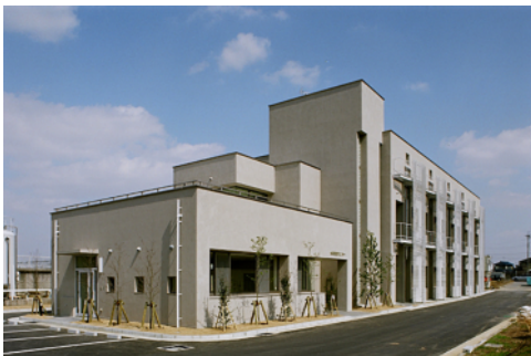
水質管理センター全景
