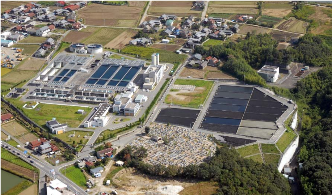
東播磨利水事務所 (神出浄水場)
