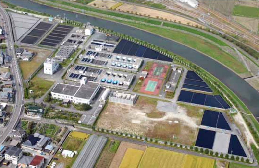
北摂広域水道事務所 (三田浄水場)
