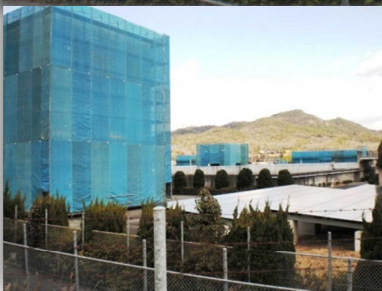
ドライ活性炭注入棟
