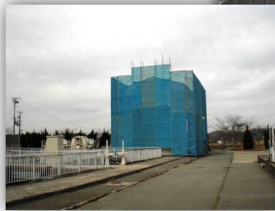
給水ポンプ棟
