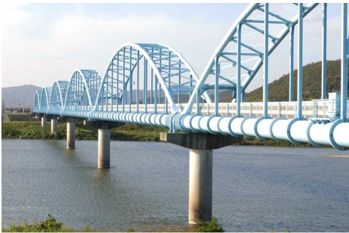
【加古川水管橋】
