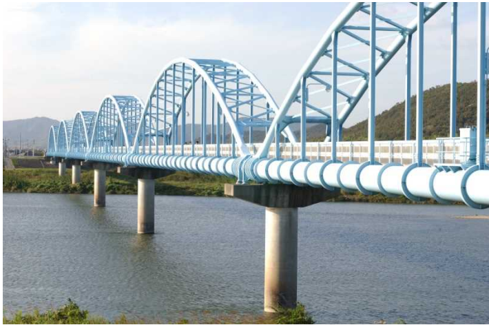
【加古川水管橋】
