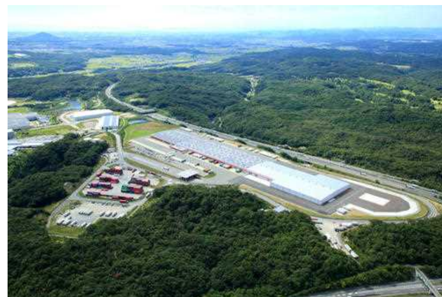
コストコホールセールジャパン(株)三木物流センター（出典：大成建設(株)HP）
