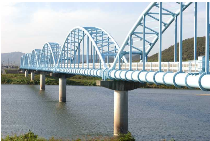
【加古川水管橋】
