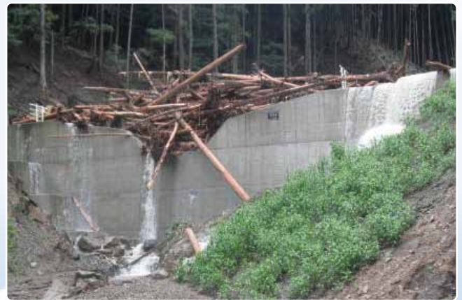
土砂・流木を捕捉し下流への被害を軽減した治山ダム ( 丹波市 )
