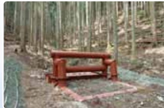
簡易防災施設を設置した災害緩衝林 ( 多可町 )
