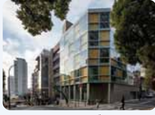
CLT+ 鉄骨ハイブリッド構造の 兵庫県林業会館 (神戸市)
