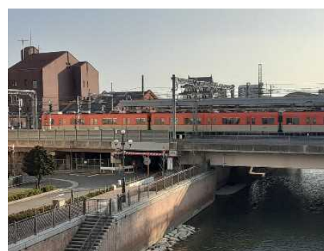
日本初の都市間電気鉄道として 開業した阪神電鉄
