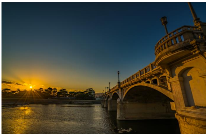
あにあんフォトコンテスト 2020 阪神間モダニズム賞 「夕照の武庫大橋」（尼崎市・尼崎市側からの武庫大橋） 玉井勝典さん
