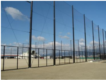
供用中の野球場（丸島地区）
