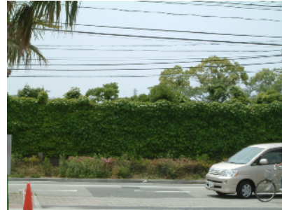
古河電気工業(株)様の事例 塀の緑化を行っている例。無機質になりがちなコンクリートの印象が緑によって緩和される。
