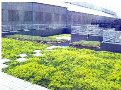
(株)大阪チタニウムテクノロジーズ様の事例 パレット型緑化資材で屋上緑化を行っている例。他にも、軽量の人工土壌や自然土壌を用いる例もある。
