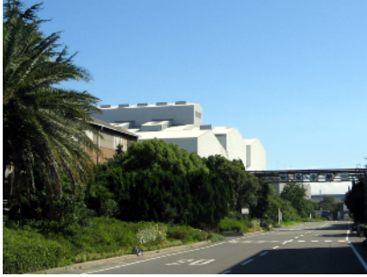
神鋼鋼線工業(株)様の事例 エントランス部分の塀を低くし、開放感のある緑地を外部からも見えるようにしている。
