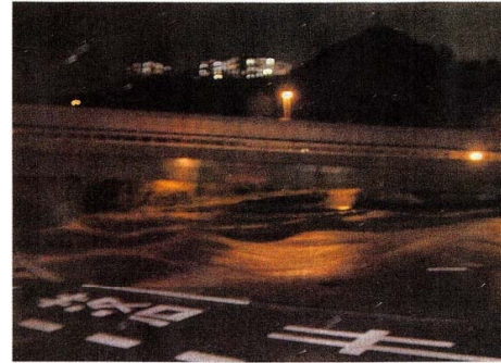
武庫川の増水で陥没した道路（20日午後8時ごろ、西宮市生瀬武庫川で）
