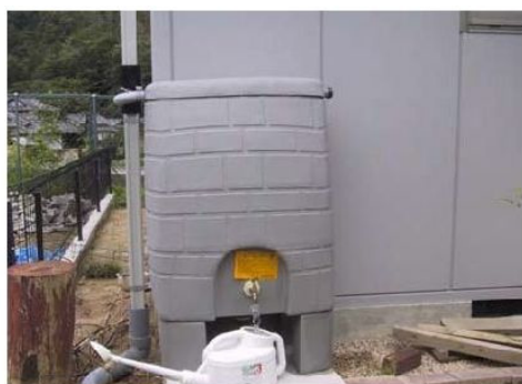
図 6-9 その他の雨水貯留・浸透の取り組み（左：雨水貯留タンク、右：浸透管・浸透樹）
