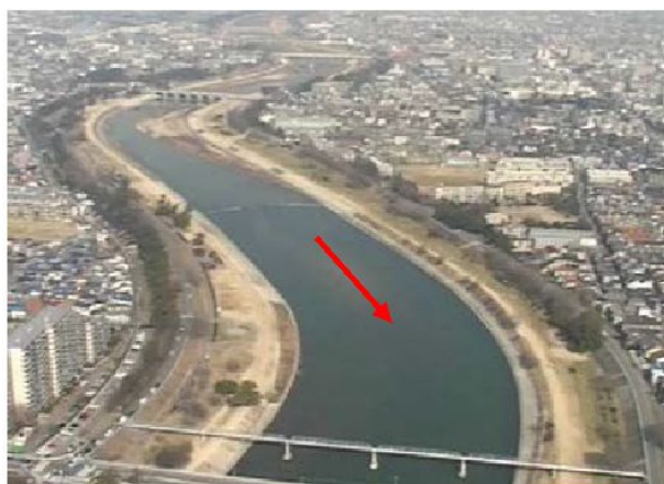
図 2-3 下流部築堤区間
