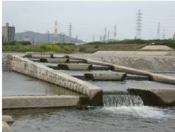
図 2-6 床止めに設置された魚道
