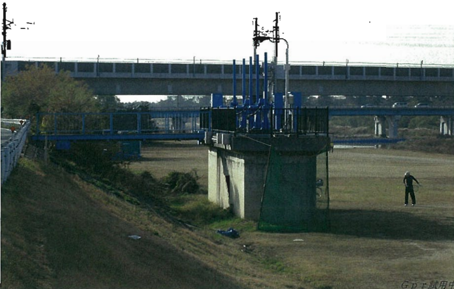
放水ゲート.JPG
