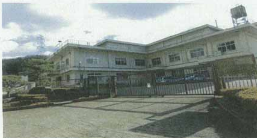
平成 16 年台風 23 号の災害後、最初に指定された 緊急待避所 (生野地区:千苺浄水場)
