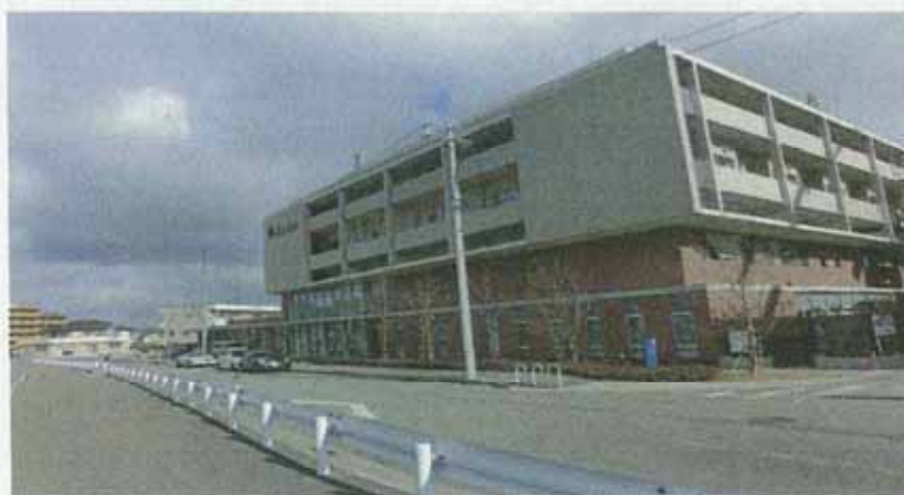
行政と地域との連携により平成 24 年に拡大指定された 緊急待避所 (② 日下部地区:恒生病院)
