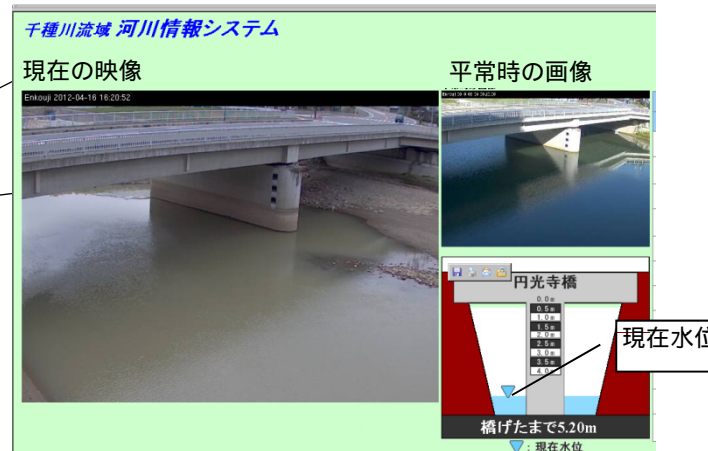
【河川監視画像画面】
