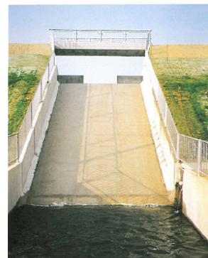
洪水調節機能をもたせた洪水吐を設置 (加古川流域土地改良事務所)
