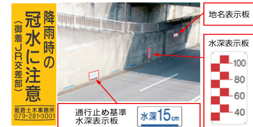
【注意喚起看板等の冠水対策】
