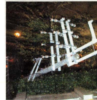
道路陥没で倒れた電柱（午後8時15分ごろ、西宮市生瀬武庫川1階で）
