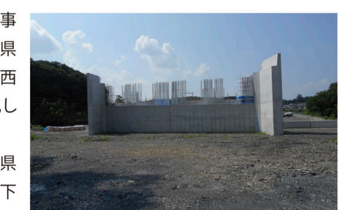
(仮称)一庫大路次川橋A2橋台
