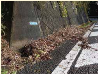
側溝の閉塞を発見
