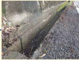
処置（撤去）完了
