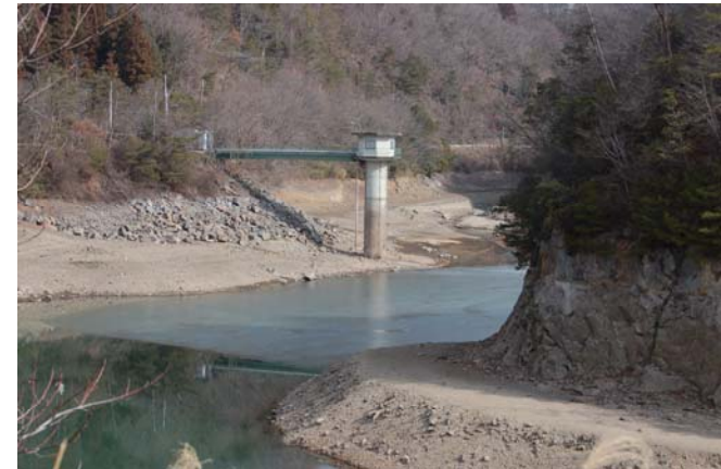
ダム渇水状況(川下川ダム)
