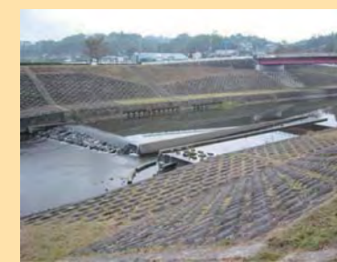
既設床止工に魚道等を設置し魚類等の移動阻害を改善した事例(三田市)
