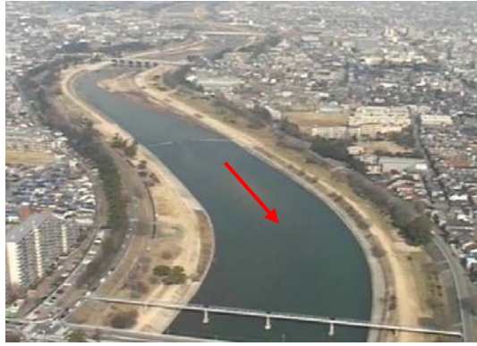
写真 2.2.1 下流部築堤区間
