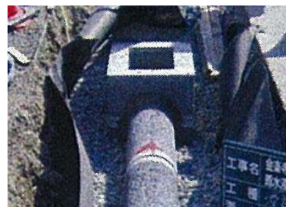
写真 2.2.11 浸透側溝
