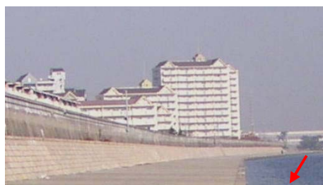
写真 2.2.5 高潮対策事業で整備した防潮堤
