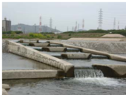
写真 2. 2. 24 床止めに設置された魚道
