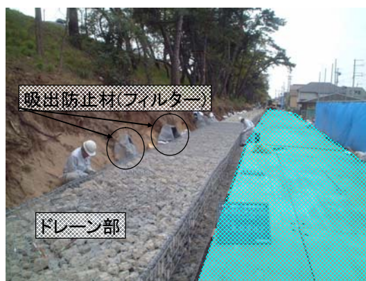
写真 2. 2. 4 堤防強化工事の例(ドレーン工)
