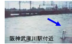
河川改修事業のきっかけとなった昭和58年洪水
