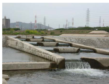
写真 2.2.24 床止めに設置された魚道
