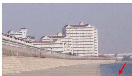
写真 2.2.5 高潮対策事業で整備した防潮堤
