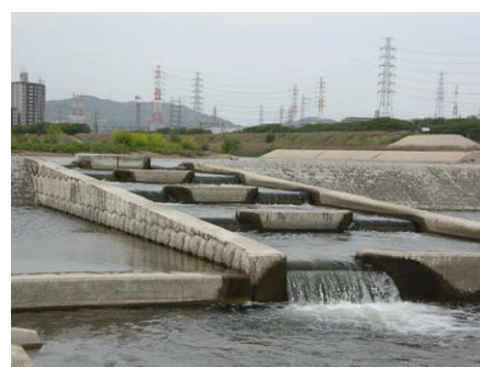
写真 2.2.24 床止めに設置された魚道
