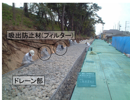
写真 2.2.4 堤防強化工事の例（ドレーン工）
