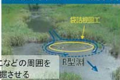
\* 木杭や根固工などの周囲を水流により洗掘させる
