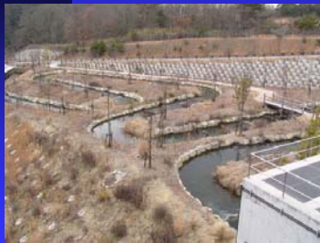
多自然型魚道(青野川、青野ダム)
