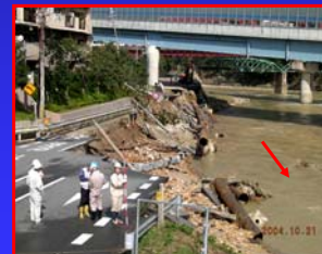
生瀬橋上流右岸側
