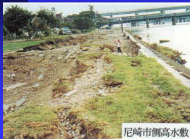
尼崎市側高水敷
