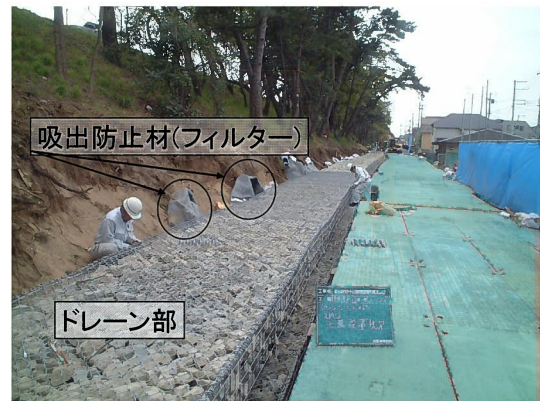
写真 2.2.4 堤防強化工事の例（ドレーン工）
