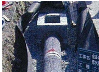
写真 2. 2. 11 浸透側溝
