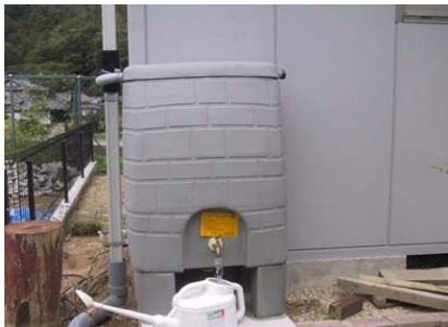
写真 2. 2. 10 雨水貯留タンク
