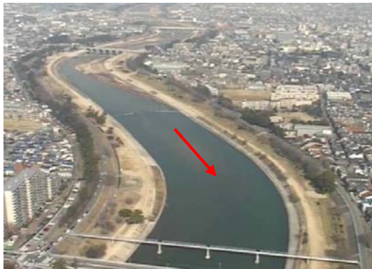
写真 2.2.1 下流部築堤区間
