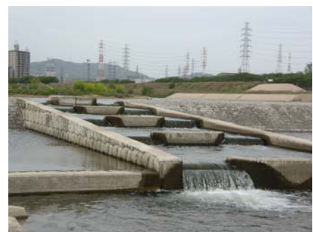
写真 2.2.24 床止めに設置された魚道
