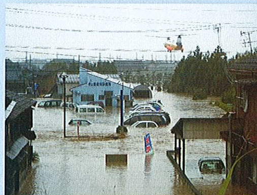
かりやたがわ 刈谷田川破堤による 中之島町浸水状況 (平成16年7月13日)
