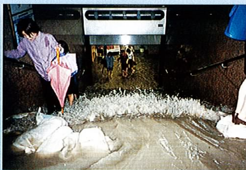
集中豪雨で博多の 地下街に流れ込む雨 (平成11年6月29日)
