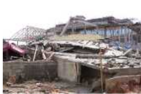
津波による建物破壊
