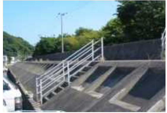
海岸や川沿いにある堤防・防潮堤
