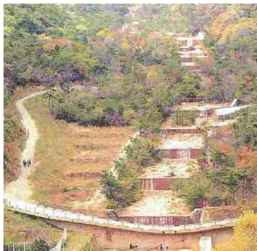
写真 2.1.10 太多田川砂防えん堤群
