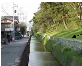
写真 4.1.1 ドレーン工法※の施工例
