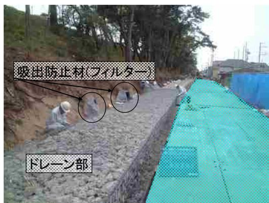
写真 2.2.4 堤防強化工事の例（ドレーン工）
