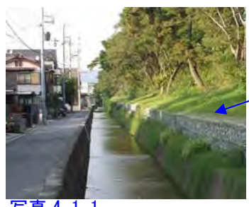
写真 4.1.1 ドレーン工法*の施工例
