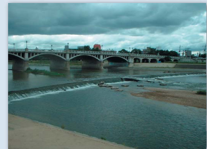
武庫大橋下流の堰
