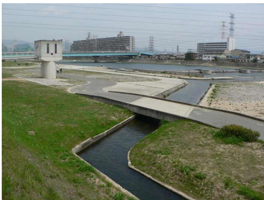
百間樋井堰と水門への導水路（西宮市）
