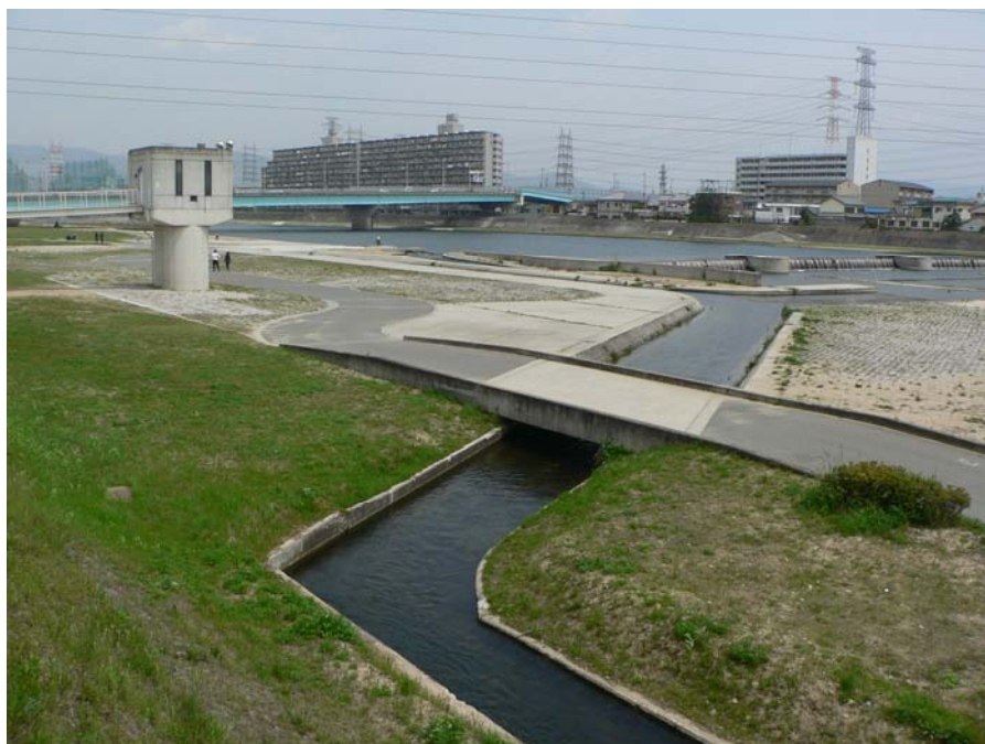
百間樋水門への導水路（西宮市）
