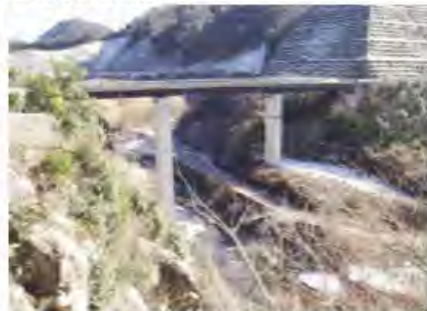
下流より清地大橋を望む
