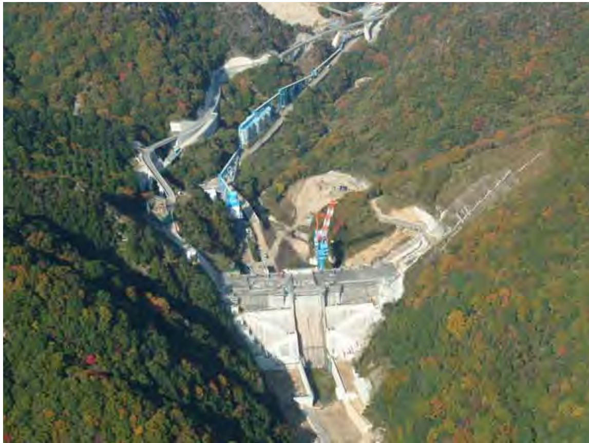
本体工事実施中 (H15.11)
