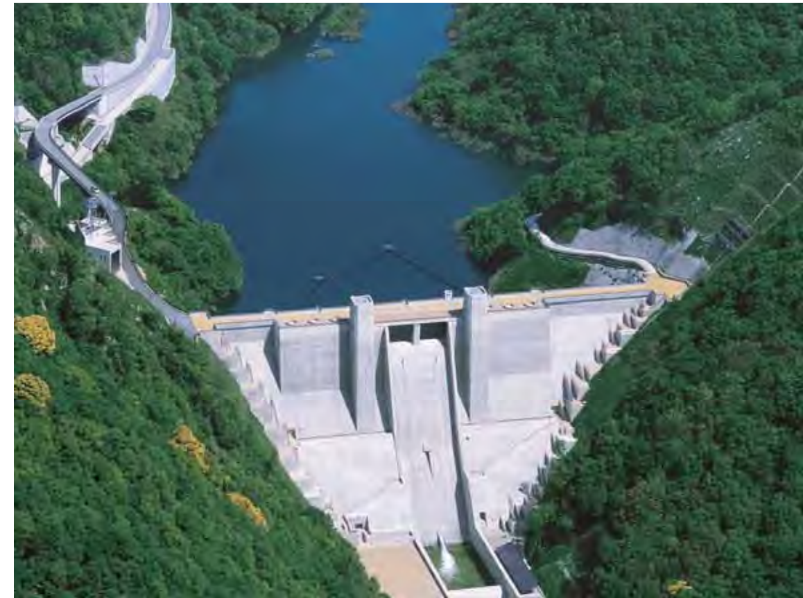
試験湛水実施中
