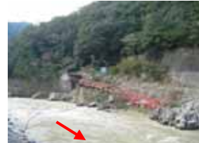
洪水により流された武田尾橋
