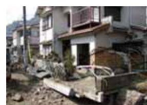
洪水により被災した家屋
