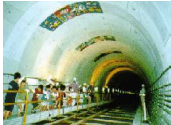
施設(貯留管)の内部
